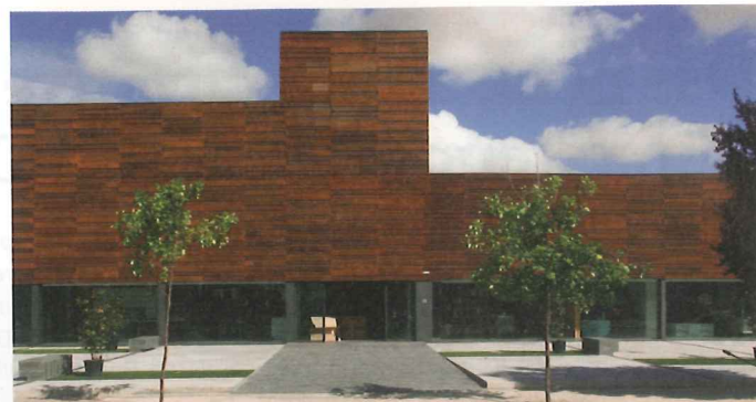
"Fassaden aus unbehandeltem Lochblech entwickeln einen besonderen Charme durch die gewollte Korrosion (Foto: Imar)"
