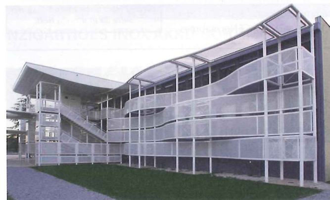
"Wenig Aufwand, viel Wirkung: Lochblechpaneele lockern triste Fassaden auf. (Foto: RMIG)"
