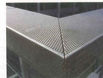
"Lochblech im Detail: Breites Brüstungsgeländer (Foto: Schiavetti)"
